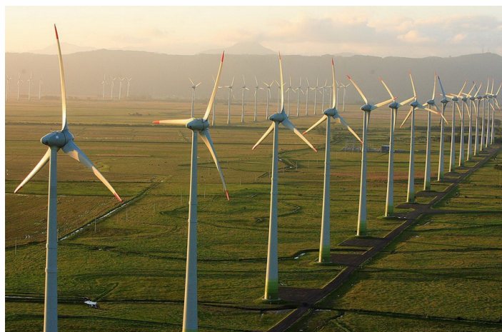
Figura 1: Parque eólico de Osório, no Rio Grande do Sul
